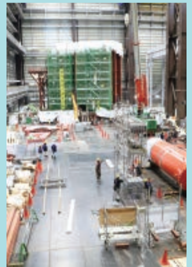
楳葉町にできた廃炉モックアップ施設の内部
